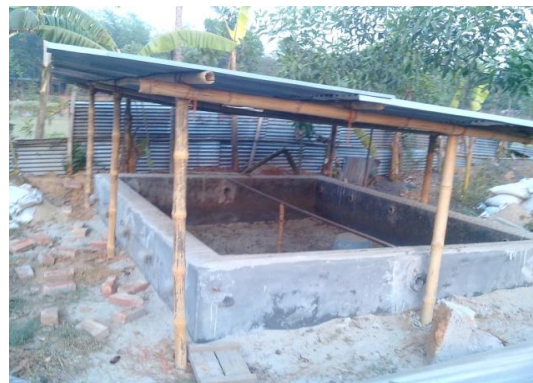
(d) Drying bed 2 with rigid cover
